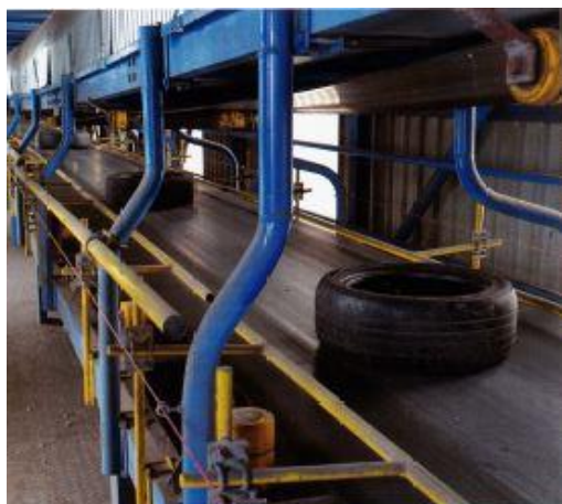
Linka na dávkovanie opotrebovaných pneumatík
