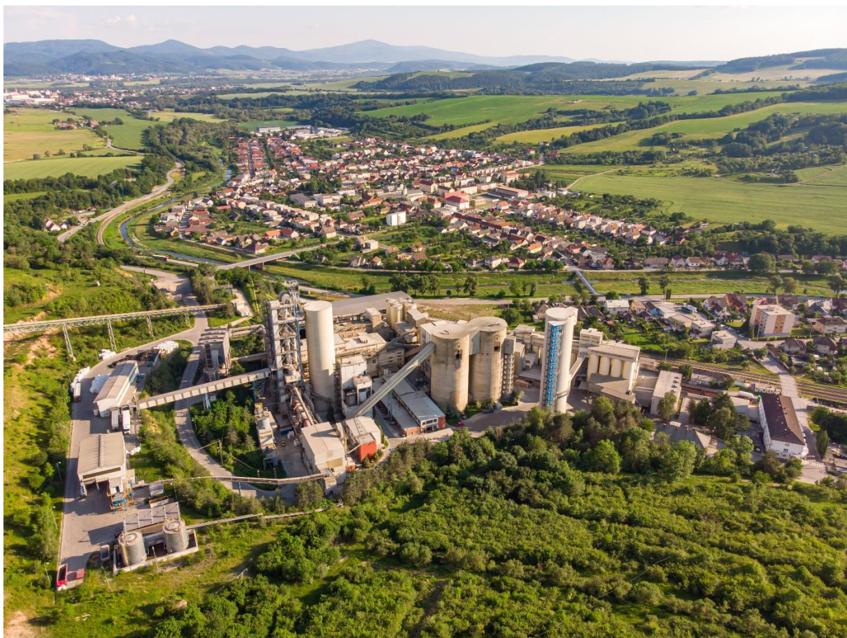
Cementáreň CEMMAC a.s. v obci Horné Srnie
